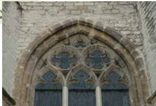
Figuur 7: Voorbeeld van natuursteenherstel in het interbellum. Het gebruik van Ettringer tufsteen aan de Sint-Willibrordusbasiliek te Hulst.
