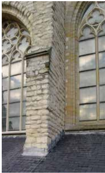
Figuur 6: Voorbeeld van natuursteenherstel rondom WO I. Gebruik van Obernkirchener zandsteen ter vervanging van Ledesteen. Onze-Lieve-Vrouweke te Breda.
