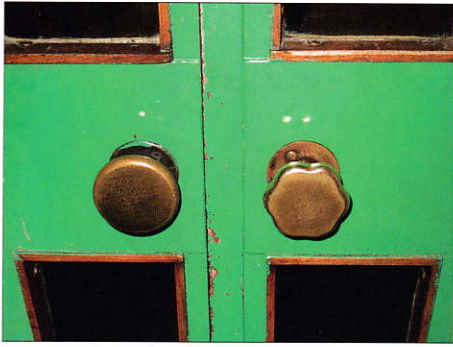
Deurknoppen op de goederenlift uit de kelder, de gekartelde kan draaien, de gladde is een vaste knop
