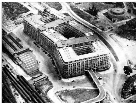
Luchtfoto van het Groothandelsgebouw in aanbouw
