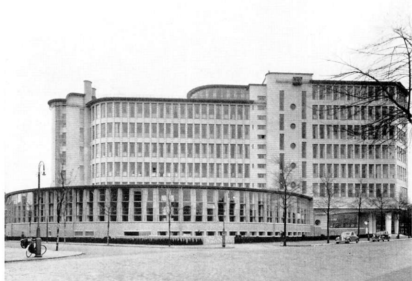
Aanzicht langsgevel, oorspronkelijke situatie
