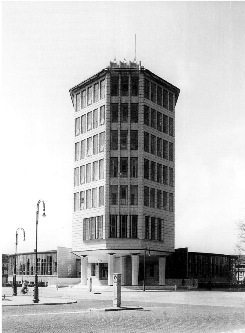
Voorzijde oorspronkelijke situatie, let op het reliëf in de gevel
