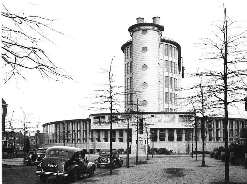
Aanzicht achterkant, oorspronkelijke situatie
