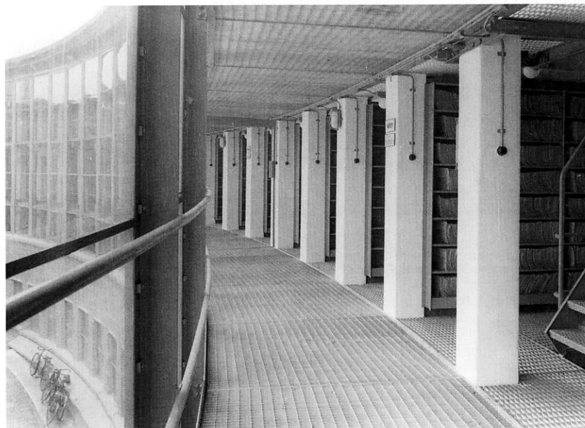
Interieur archiefring, oorspronkelijke situatie
