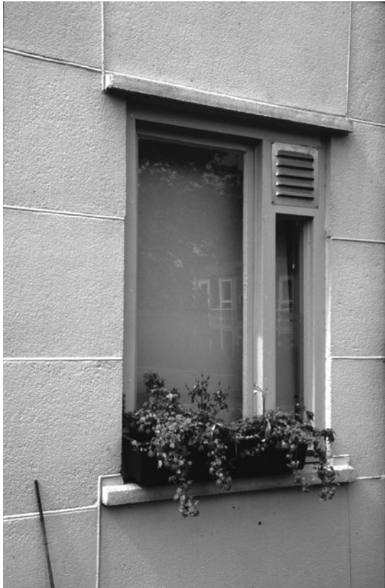
Afbeeldingen 4.4.110 en 111: de gevels werden geschilderd; voegen dicht gezet; houten ventilatieroosters vervangen door aluminium en er werden roosters in de gevel toegevoegd. H. Zijlstra 2002.
