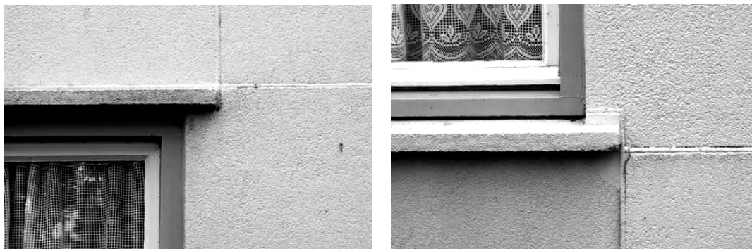
Afbeeldingen 4.4.80 en 81: een boven- en onderdorpel in de voorgevel. H. Zijlstra, 2002.
