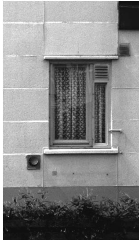
Afbeeldingen 4.4.110 en 111: de gevels werden geschilderd; voegen dicht gezet; houten ventilatieroosters vervangen door aluminium en er werden roosters in de gevel toegevoegd. H. Zijlstra 2002.
