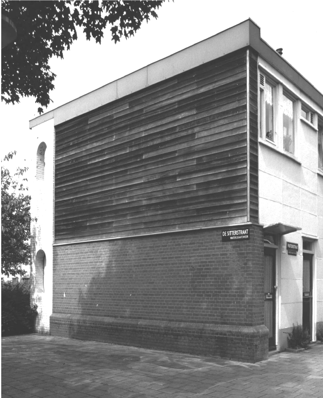
Afbeelding 4.4.107: al voor de onderhoudsbeurt rond 1990 werden de kopgevels geheel dan wel gedeeltelijk van metselwerk voorzien. H. Zijlstra, 2002.
