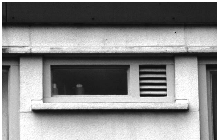
Afbeeldingen 4.4.101 en 102: de in de gevel opgenomen ventilatievoorziening. NAI archief MELK, NM 26-2. H. Zijlstra, 2002.
