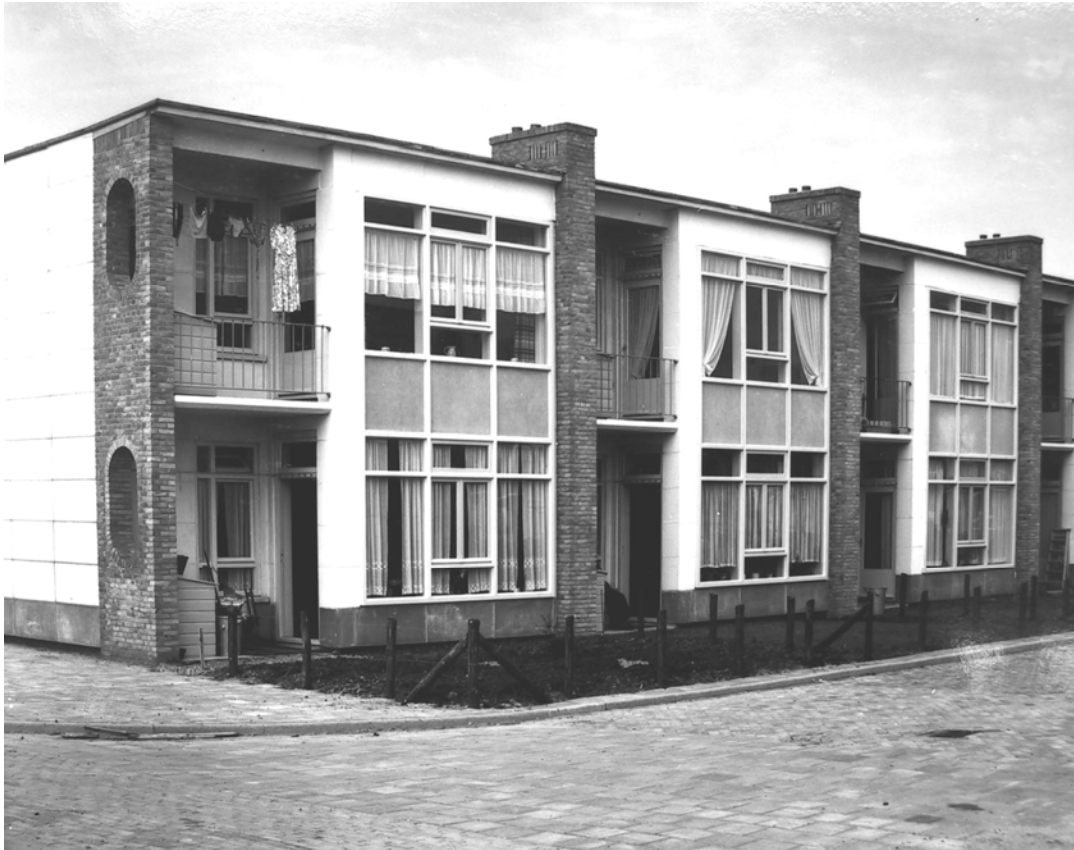
Afbeelding 4.4.51: de achtergevels, die door de verkavelingsvorm ook aan de straat kunnen liggen. De naden tussen betonplaatjes, om de grote puien heen, zijn te zien en de onderste panelen zijn donkerder van kleur. Gemeente Archief Amsterdam, 1950.
