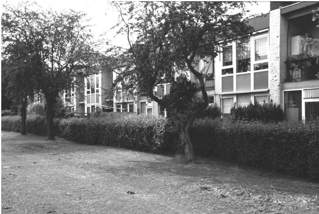
Afbeelding 4.4.112: de achterpuien werden vervangen door kunststof omlijst door (Trespa) beplating. Men kon ervoor kiezen om de indeling te wijzigen en het terras op de begane grond dicht laten zetten. H. Zijlstra, 2002.
