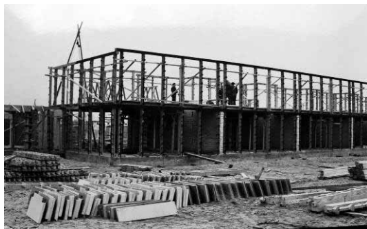
Abbeidingen 4.4.122 en 123: de woningen in aanbouw in systeembouw met kleine elementen van beton en het interieur in 1950. Gemeente Archief Amsterdam.
