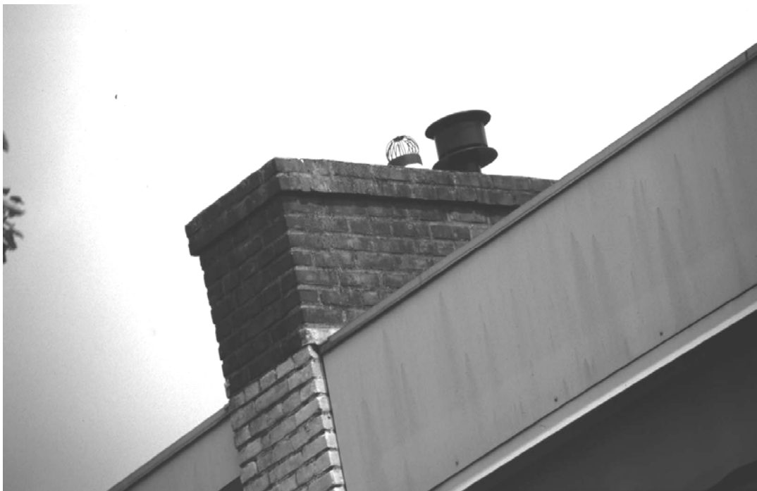
Afbeeldingen 4.4.108-en 109: er werden dakranden van een beplating (Trespa) aangebracht; nieuwe schoorsteenkappen geplaatst en de schoorstenen zelf werden gedeeltelijk wit geschilderd. H. Zijlstra, 2002.
