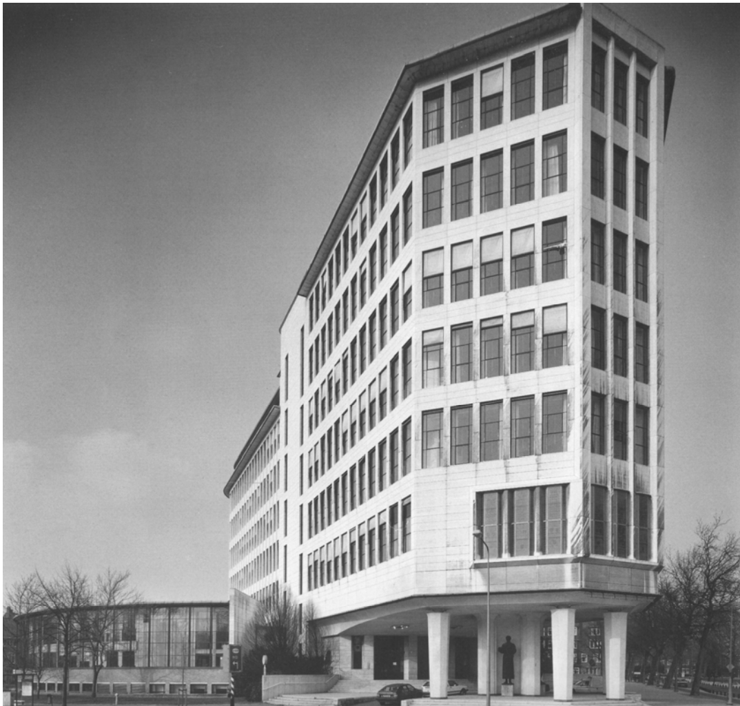
Afbeelding 4.1.145: de nieuwe structuur van de gevel die aan vervuiling onderhevig is. De vlaggenmasten waren verdwenen. Mens, R., De Sociale Verzekeringsbank. Architectonische Aspecten , Amstelveen 1991.
