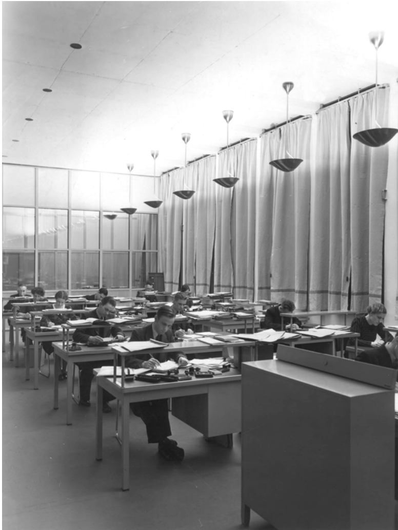
Afbeelding 4.1.119: het interieur met kunstlicht verlichting van indirecte armaturen. LIAG archief.
