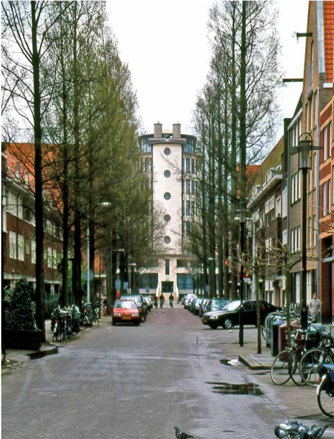
Afbeelding 4.1.15: de Rijksverzekeringsbank gezien vanuit de huidige Gerrit van der Veenstraat. H. Zijlstra 2001.
