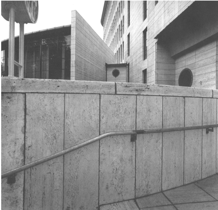
Afbeelding 4.1.142: de afwerking met natuursteen Travertin van trappen en muurtjes. H. Zijlstra 2001.
