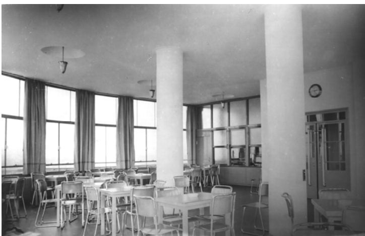
Afbeelding 4.1.86: de sparingen voor de armaturen in het plafond. LIAG archief.
