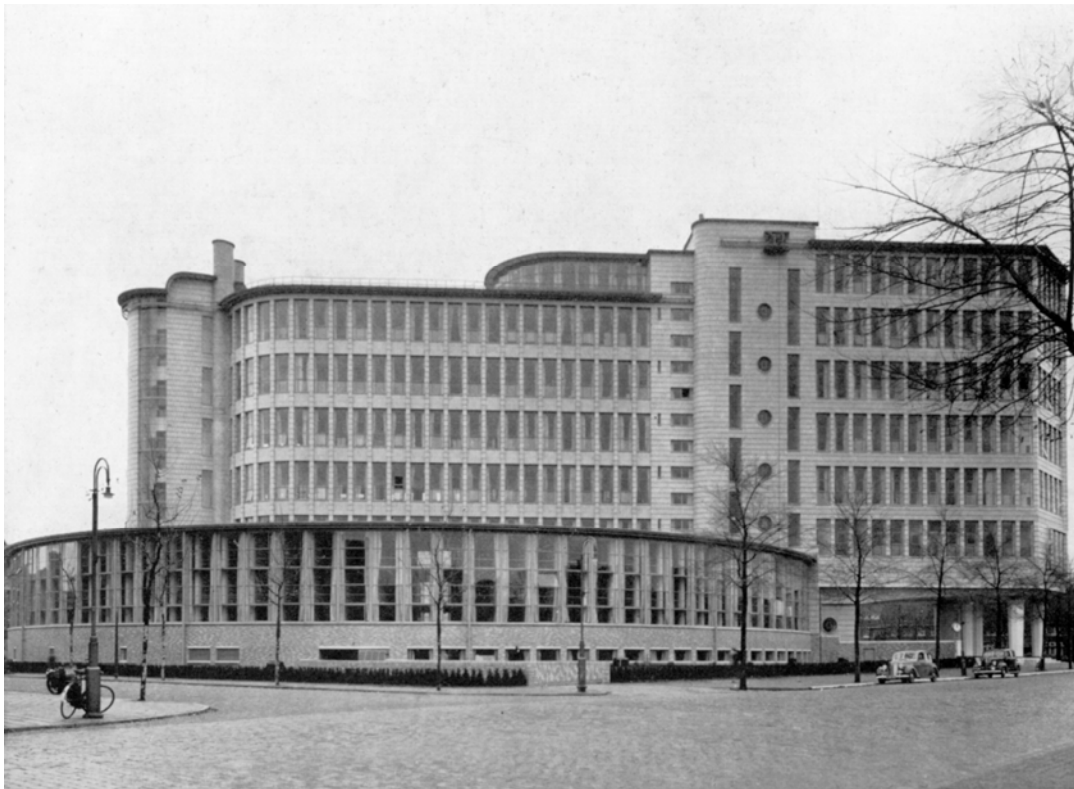
Afbeelding 4.1.62: de langsgewel met de dakopbouw en het terras van de Rijksverzekeringbank. LIAG archief.
