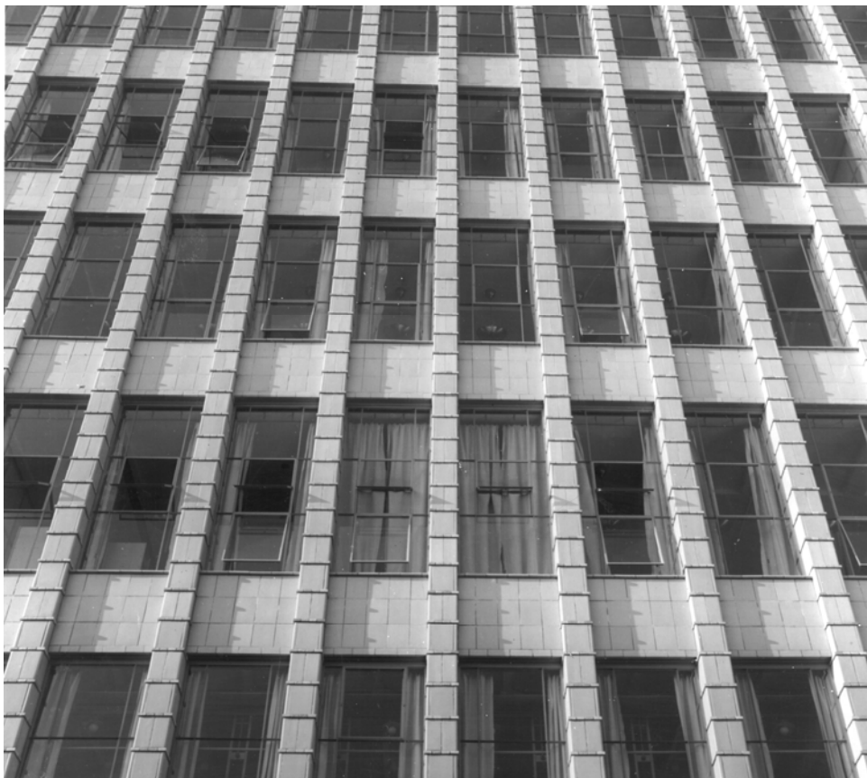
Afbeelding 4.1.21: een deel van de oorspronkelijke gevel van de Rijksverzekeringsbank in 1939. LIAG archief. (Afbeelding is identiek aan 4.1.100 op pagina 66).
