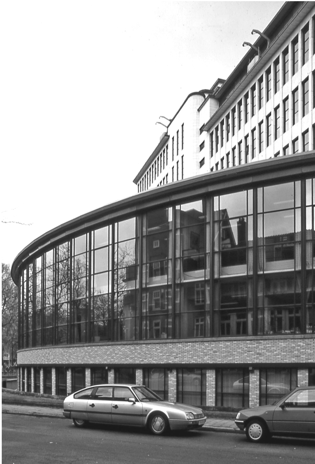
Afbeelding 4.1.151: de gemêleerde stenen van de archiefkring nadat deze weer was opgebouwd in 1993, de extra verdieping in dit bouwdeel en de gevelreinigingsinstallatie door middel van een gondelconstructie op het dak in plaats van een rail langs de dakrand. H. Zijlstra 2002.
