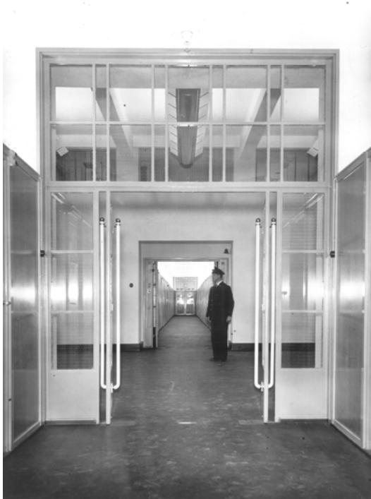
Afbeelding 4.1.74: het interieur van de gangen met puien van staal en glas. LIAG archief.
