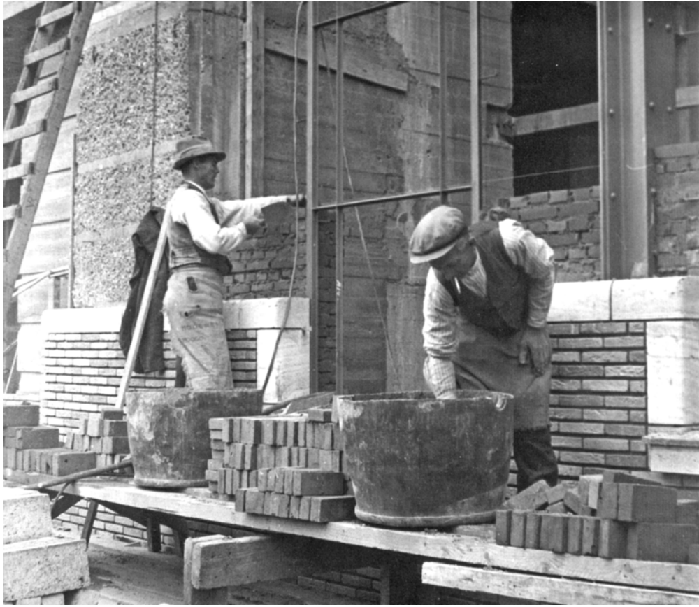
Afbeelding 4.1.101: het metselwerk van de archiefring wordt aangebracht en afgewerkt met natuursteenbanden. Mens, R., De Sociale Verzekeringsbank. Architectonische Aspecten , Amstelveen 1991.
