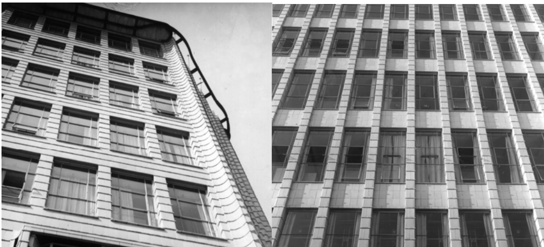
Afbeeldingen 4.1.99 en 100: de horizontale textuur van de gevel van de voorbouw en de meer verticale textuur van de gevel van de achterbouw. LIAG archief. (Afbeeldingen zijn identiek aan 4.1.147 op pagina 95 en 4.1.21 op pagina 18).
