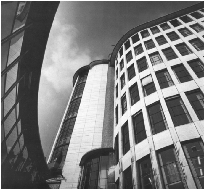
Afbeelding 4.1.141: de nieuwe structuur van de gevel sinds 1993. De raamopeningen in het trappenhuis en de 'hangsteigerbaan' zijn verdwenen. Mens, R., De Sociale Verzekeringsbank. Architectonische Aspecten , Amstelveen 1991.
