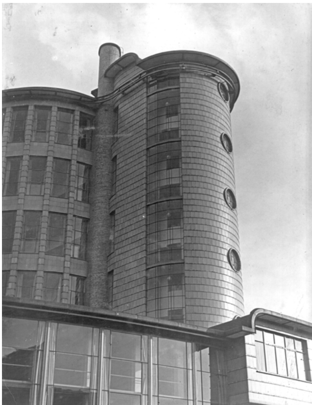
Afbeelding 4.1.122: de schoorsteen en de 'hangsteigerbaan' net onder de dakrand. LIAG archief.
