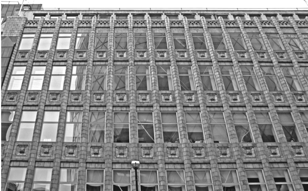
Afbeelding 4.1.20: een deel van de gevel van het Holland House van H.P. Berlage in Londen. H. Zijlstra 2004.
