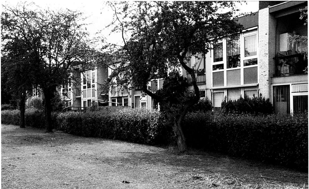
16 De achtergevels na de onderhoudsbeurt, foto H. Zijlstra april 2002.
