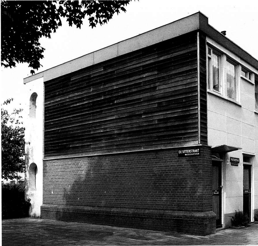
15 De kopgevels en dakranden na de onderhoudsbeurt, foto H. Zijlstra april 2002.
