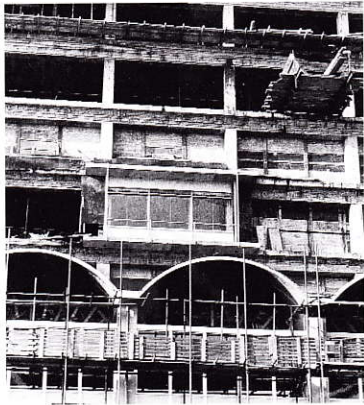
Het Paketpostgebouw, hoogbouw en laagbouw deel in aanbouw met een proef van de gevelsluitende pui. | Uit: NAI MELK
