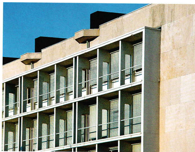
Gevelafwerking van het Briefpostgebouw aan de zuidzijde met natuursteen bekleding en balkons. | Foto: R. Rawi, 2003
