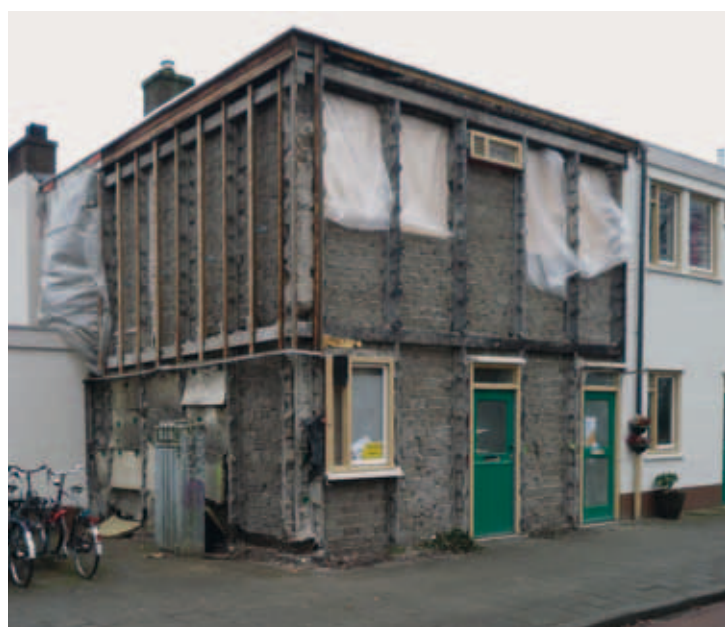
AFB.10. Hoekwoning ontmanteld voor de restauratie in 2010 (foto Hielkje Zijlstra)
