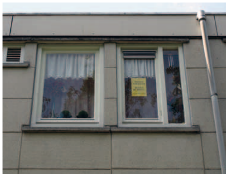
AFB.14. Voorgevel met aanpassingen uit 1990 (verf, voegwerk, dakrand) en de poster 'Behoud Jeruzalem' die sinds 2000 vele gevels siert (foto Hielkje Zijlstra)
