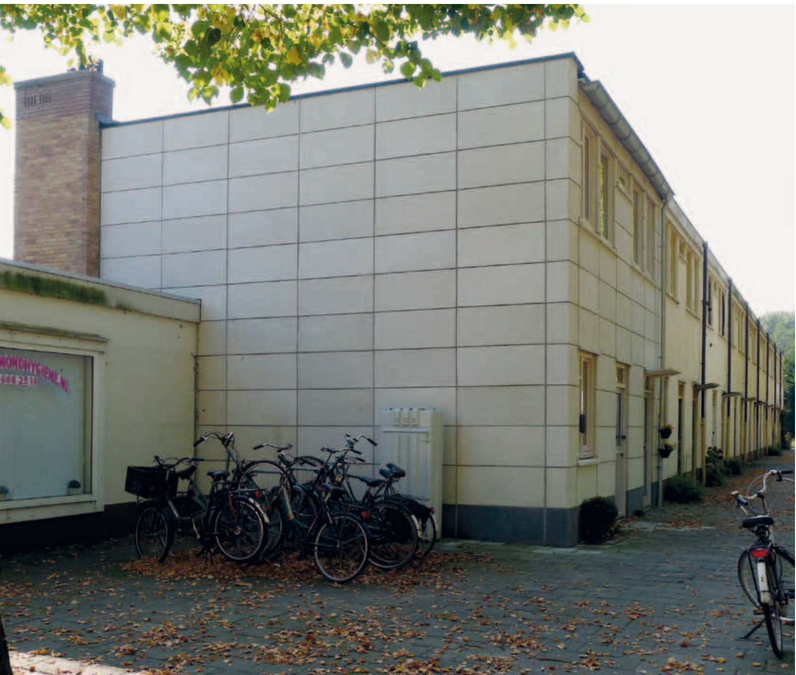
AFB.11. Hoekwoning opgeleverd na de restauratie in 2011 (foto Hielkje Zijlstra)
