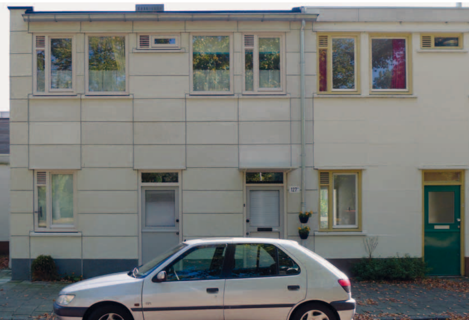
AFB.18. Voorgevel in 2011 na restauratie (foto Hielkje Zijlstra)
