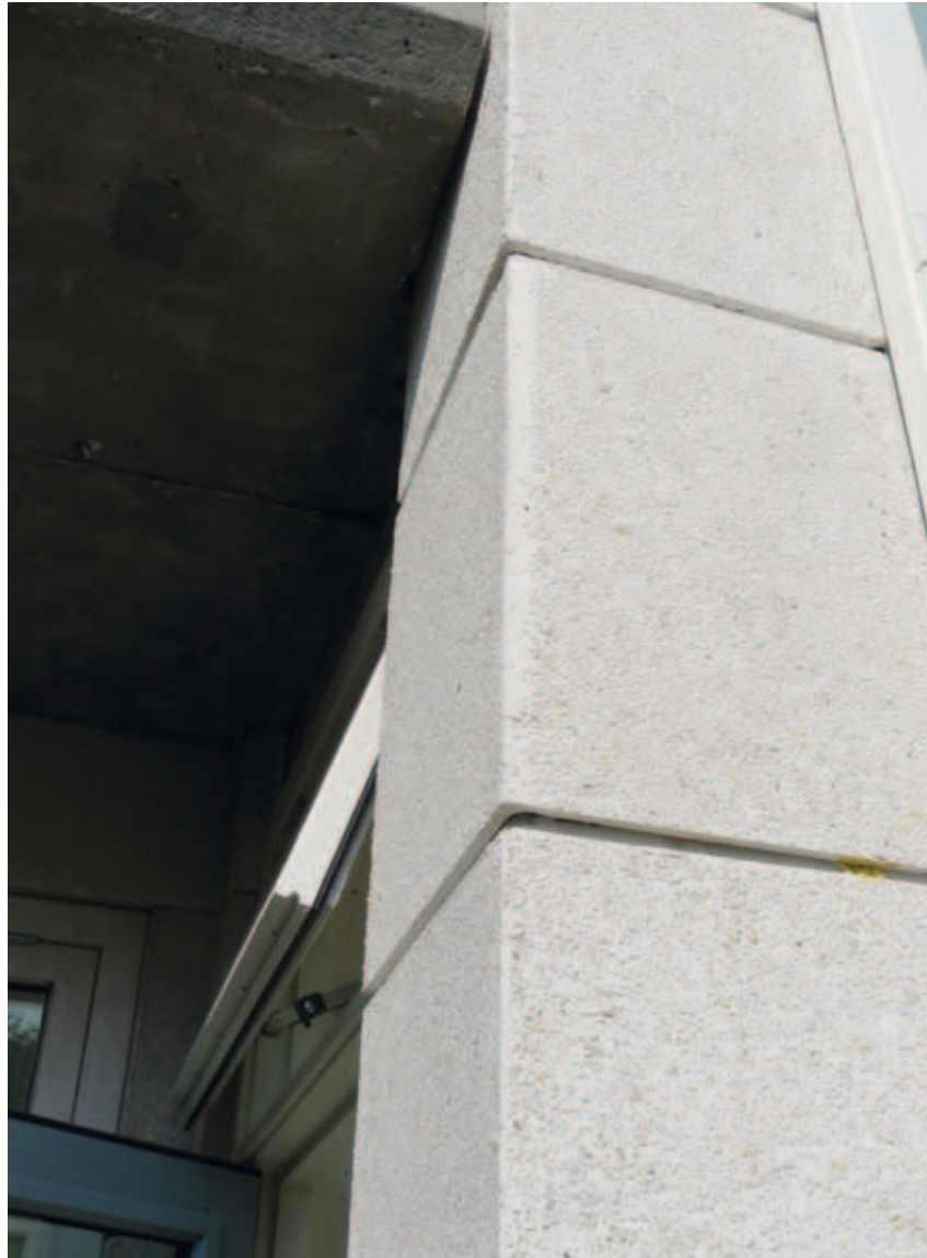
AFB.16. Gevelelement van de proefwoning waarbij op de hoek het verschil in structuur te zien is, 2010 (foto Hielkje Zijlstra)
