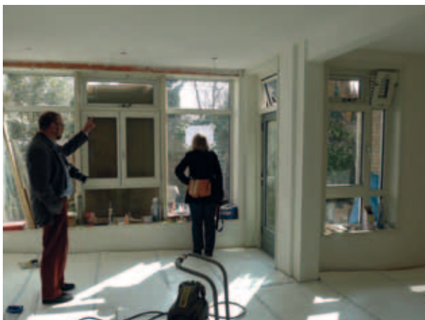
AFB.20. Interieur van de gerestaureerde woning: let op de dikte van het raamhout bij de kleine raampjes (foto Hielkje Zijlstra)
