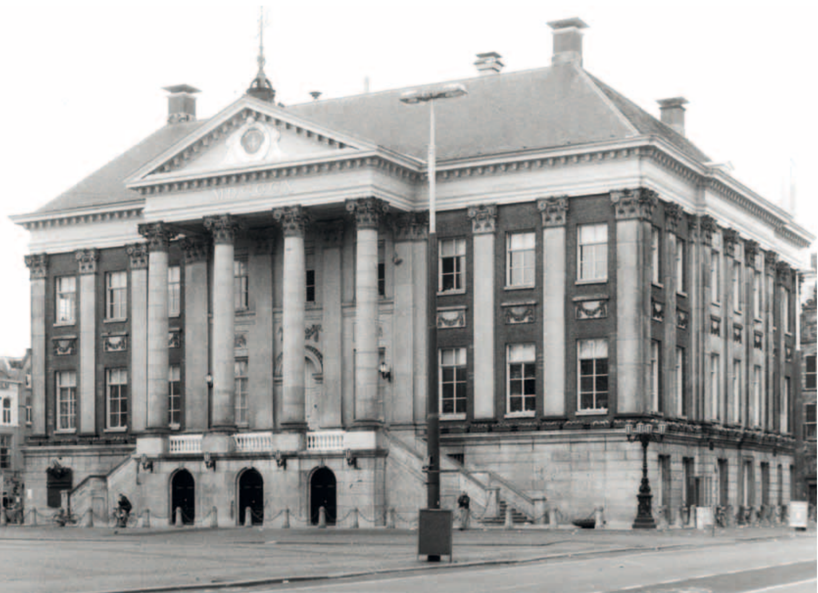
AFB.10. De voorgevel van het Stadhuis in Groningen (foto Thomas von der Dunk)
