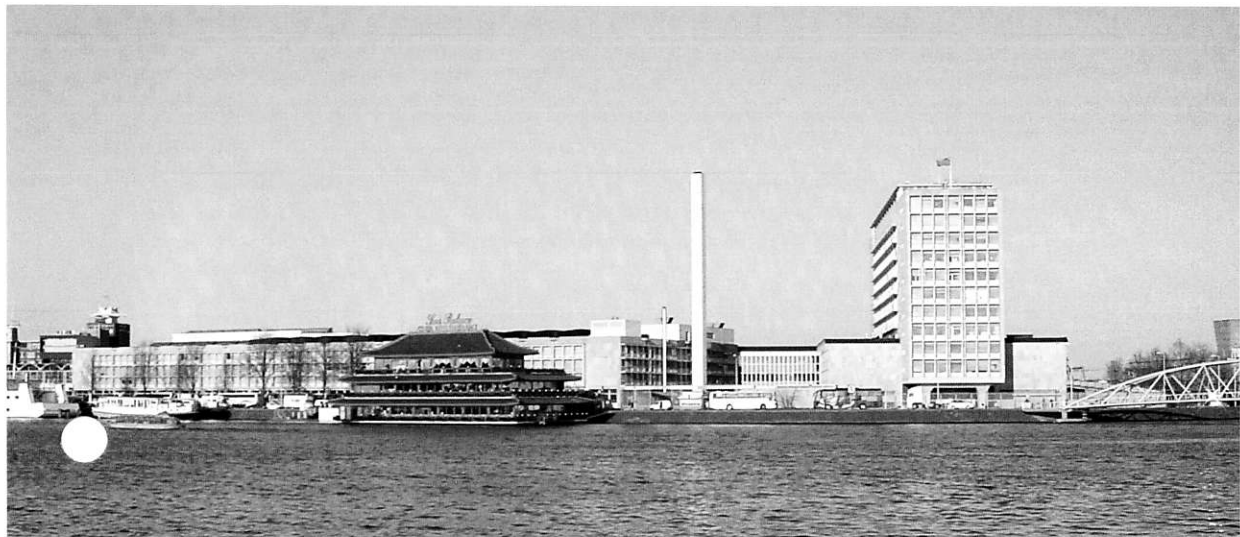
7 Aanzicht van het stationspostkantoor vanaf de Prins Hendrikkade. Foto R. Rawi, 2003.
