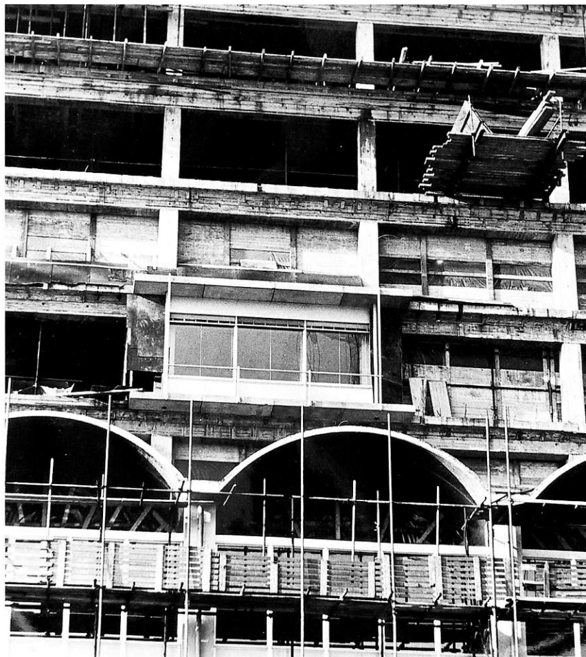
13 Het Pakketpostgebouw, hoogbouw- en laagbouwdeel in aanbouw met een proef van de gevelsluitende pui. Collectie Nederlands Architectuurinstituut, Rotterdam, archief MELK (Bureau-archieven Karsten-Merkelbach-Elling)
