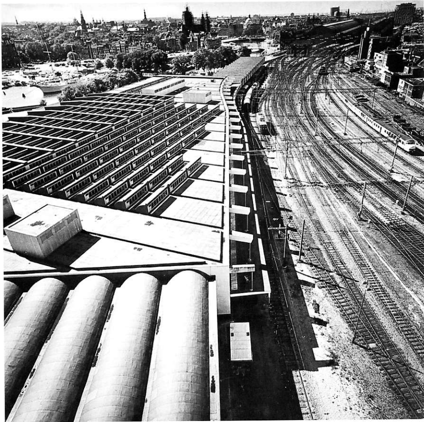
16 Het dakaanzicht van het Briefpostgebouw in 1968. Collectie Nederlands Architectuurinstituut, Rotterdam, archief MELK (Bureau-archieven Karsten-Merkelbach-Elling).
