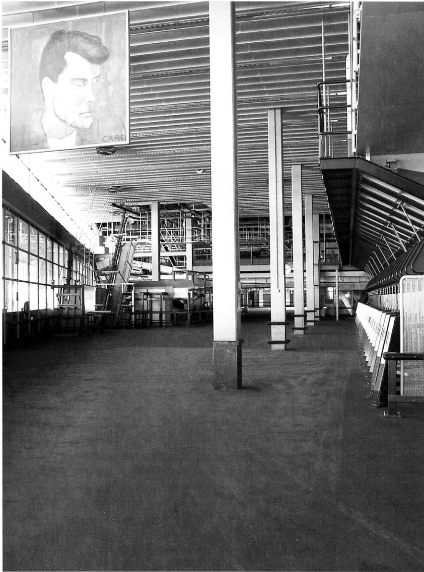
2 Het interieur van de zaal aan de perronzijde van het Briefpostgebouw. Foto H. Zijlstra, 2003.
