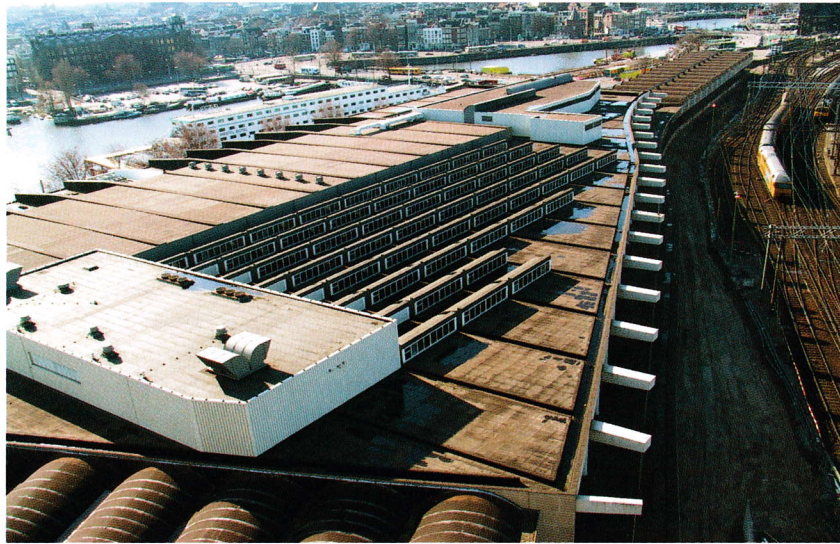
Het dak van het pakketpostgebouw waarop de installatieruimten in 1978, als dozen werden toegevoegd.
