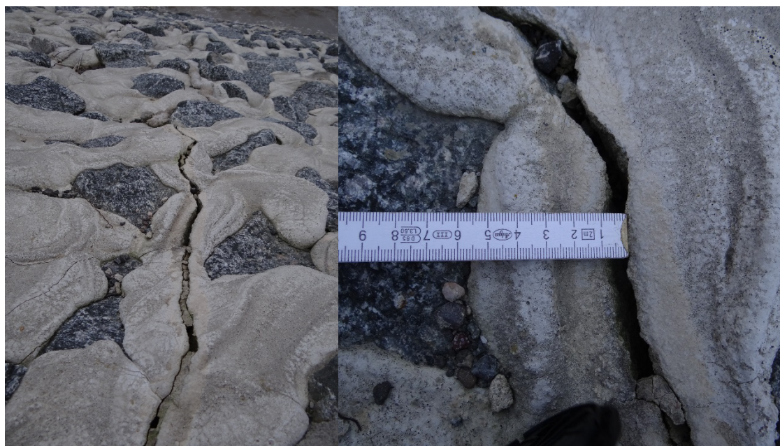
Abbildung 4: Risse des Typs 3 (Fotos: Kreyenschulte 2015).
