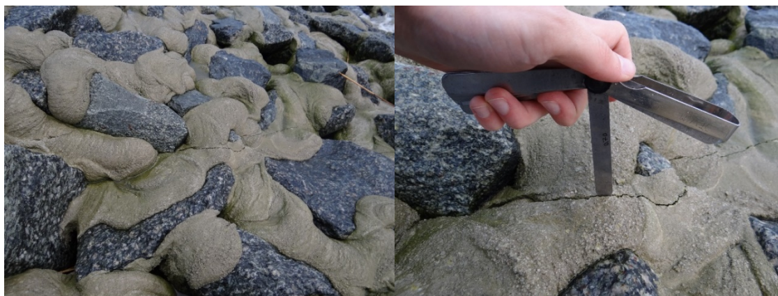
Abbildung 3: Risse des Typs 2 (Fotos: Kreyenschulte 2015).
