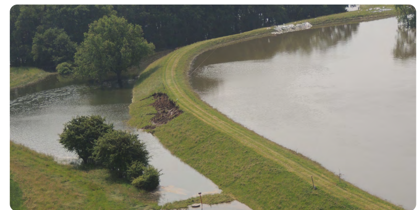
Figuur 1: Macro-instabiliteit in Saksen-Anhalt (Duitsland) zonder overstroming. Foto uit Jüpner et al. (2015).
