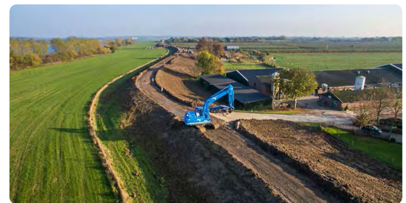
Figuur 1: Aanleg van een dijk. Bron: HWBP (2018, p.103) , foto genomen door Pascal Ogink.
