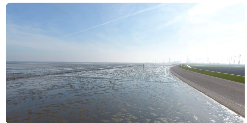
Figuur 1: Dijk aan de Waddenzee deels bedekt met asfalt en deels met gras, met ervoor een ondiep, flauw hellend slik. Foto door Jaap van Duin.
