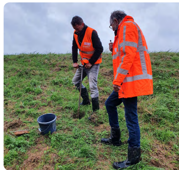
Figuur 1: Grondboring t.b.v. de analyse van het binnenwerk van een dijk. Foto door HWBP.
