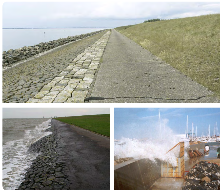
Figuur 2: Boven: Verschillende soorten ruwheidselementen en een berm aangebracht bij een dijk. Bron: FurQtop (2018, p. 103) . Onder: Golfploop en golfoverslag bij dijken in Nederland (links) en in Italië. Bron: FurQtop (2018, p.103 en p. 51) .
