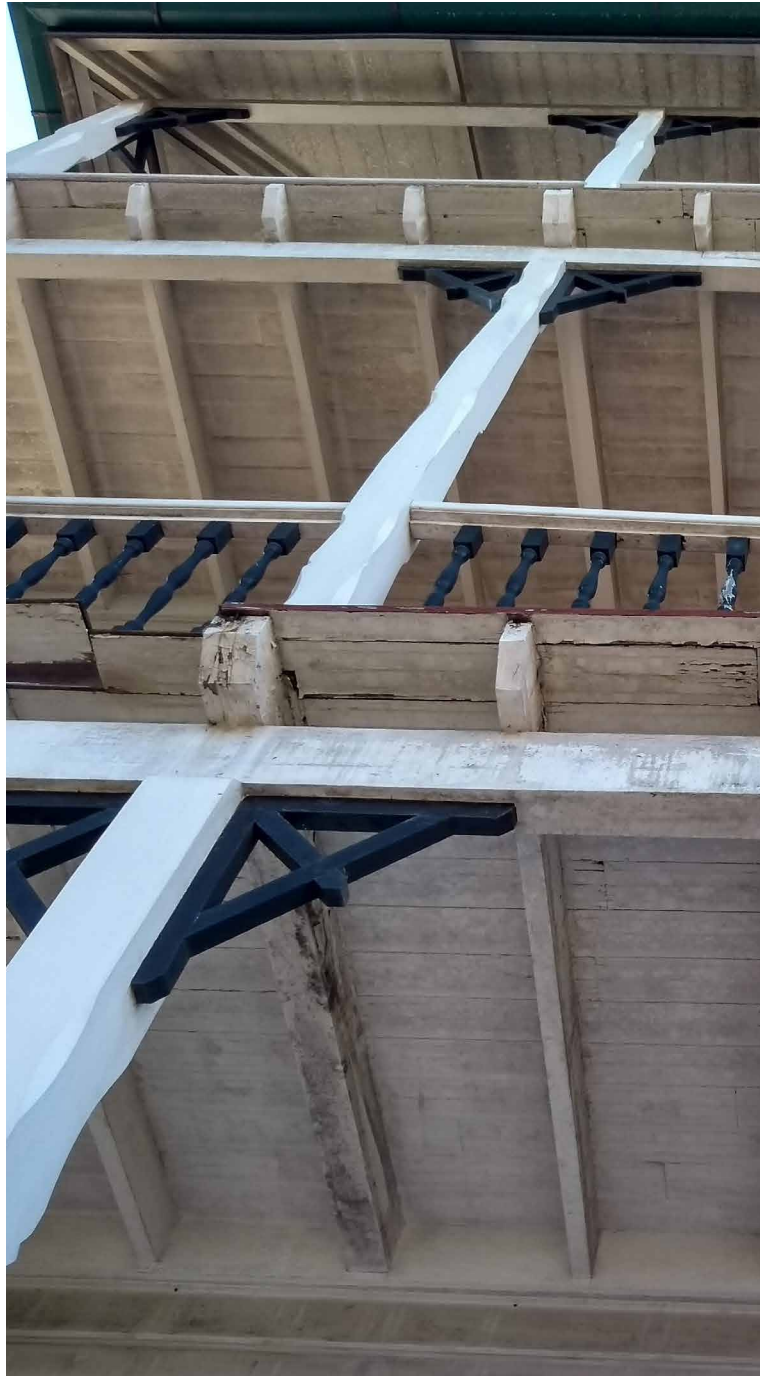
FIG. 1.2 Heerenstraat balkon Heerenstraat balcony
