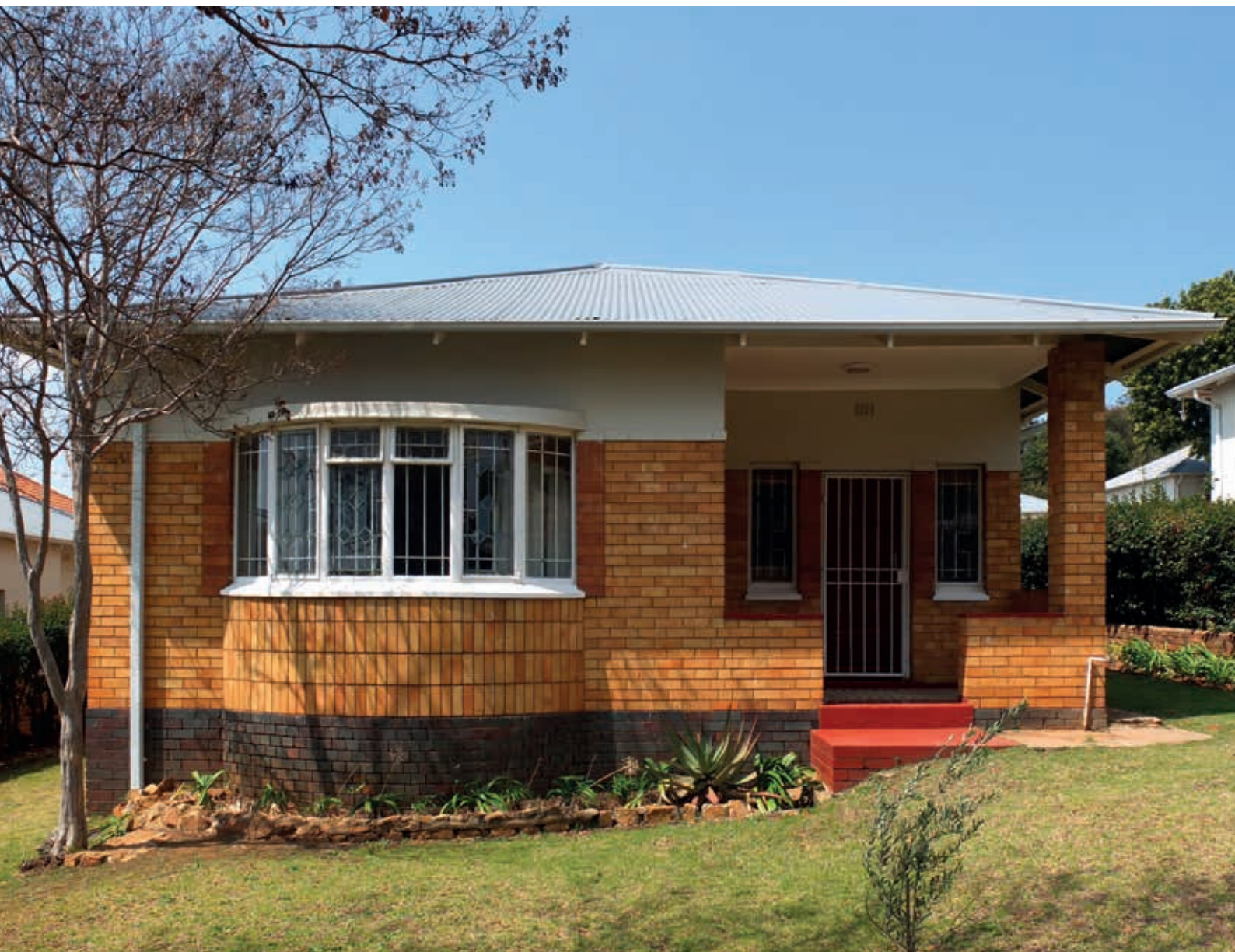
14. J.E. Ferguson en S. Stakesby-Lewis, woonhuis A.J. Du Plessis in Cottesloe, Johannesburg, gebouwd in 1943. Du Plessis was een van de professoren van het Technikon (collectie Tsica Heritage Consultants, Johannesburg)
