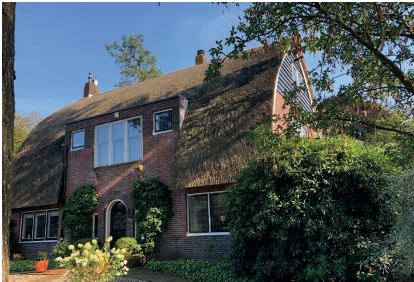
9. J.E. van Everdingen-Ferguson, villa De Huif in Wageningen, in 1927 gebouwd voor haar moeder, broers en zuster (foto Marieke Kuipers, 2018)
