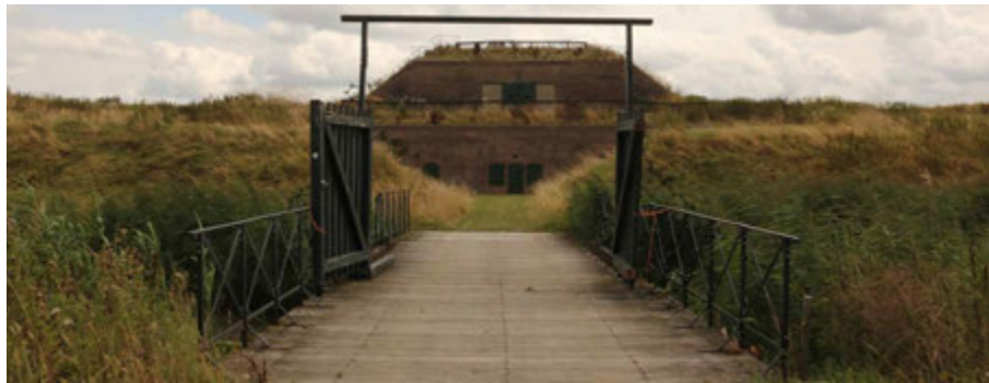
FIG. 4.83 Tull en 't Waal (NL), Werk aan de Waalse Wetering: entrance bridge and bombproof barracks (F. Marulo 2019)
