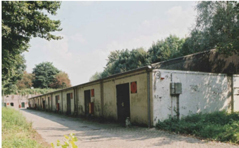
FIG. 4.67 Houten (NL), Lunet aan de Snel: the concrete shed in the courtyard before demolition (2002) (Collectie Nederlands Instituut voor Militaire Historie)
