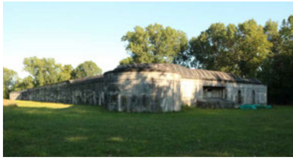
FIG. 5.78 Venice (IT), Forte Mezzacapo, concrete battery: rear side (F. Marulo 2020)
