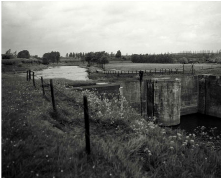
FIG. 4.4 Houten (NL): inundation sluice near Fort Honswijk (1961) (Collectie Nederlands Instituut voor Militaire Historie)
