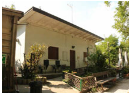
FIG. 5.66 Venice (IT), Forte Carpenedo: the external guardhouse (F. Marulo 2020)
