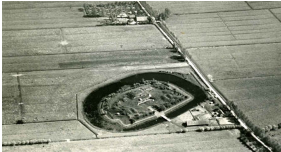
FIG. 4.81 Tull en 't Waal (NL), Werk aan de Waalse Wetering: aerial picture (1920-1940) (Collectie Nederlands Instituut voor Militaire Historie)
