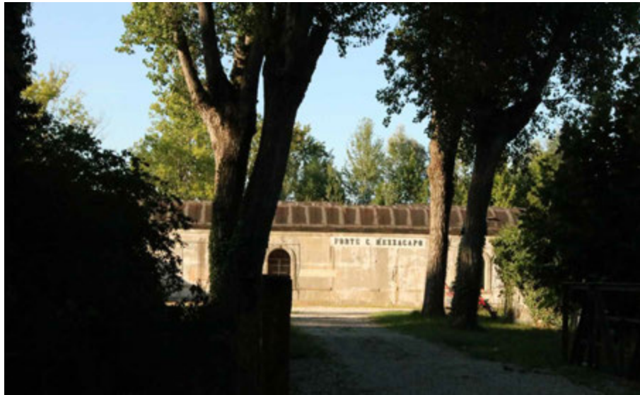
FIG. 5.74 Venice (IT), Forte Mezzacapo: entrance bridge (F. Marulo 2020)
