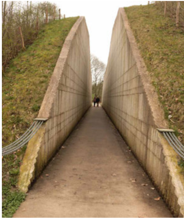
FIG. 4.34 Bunnik (NL), Fort bij Vechten: entrance cut in the earthwalls (F. Marulo 2019)
