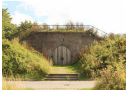
FIG. 4.78 Houten (NL), Fort 't Hemeltje: building E closed for bats (F. Marulo 2019)
