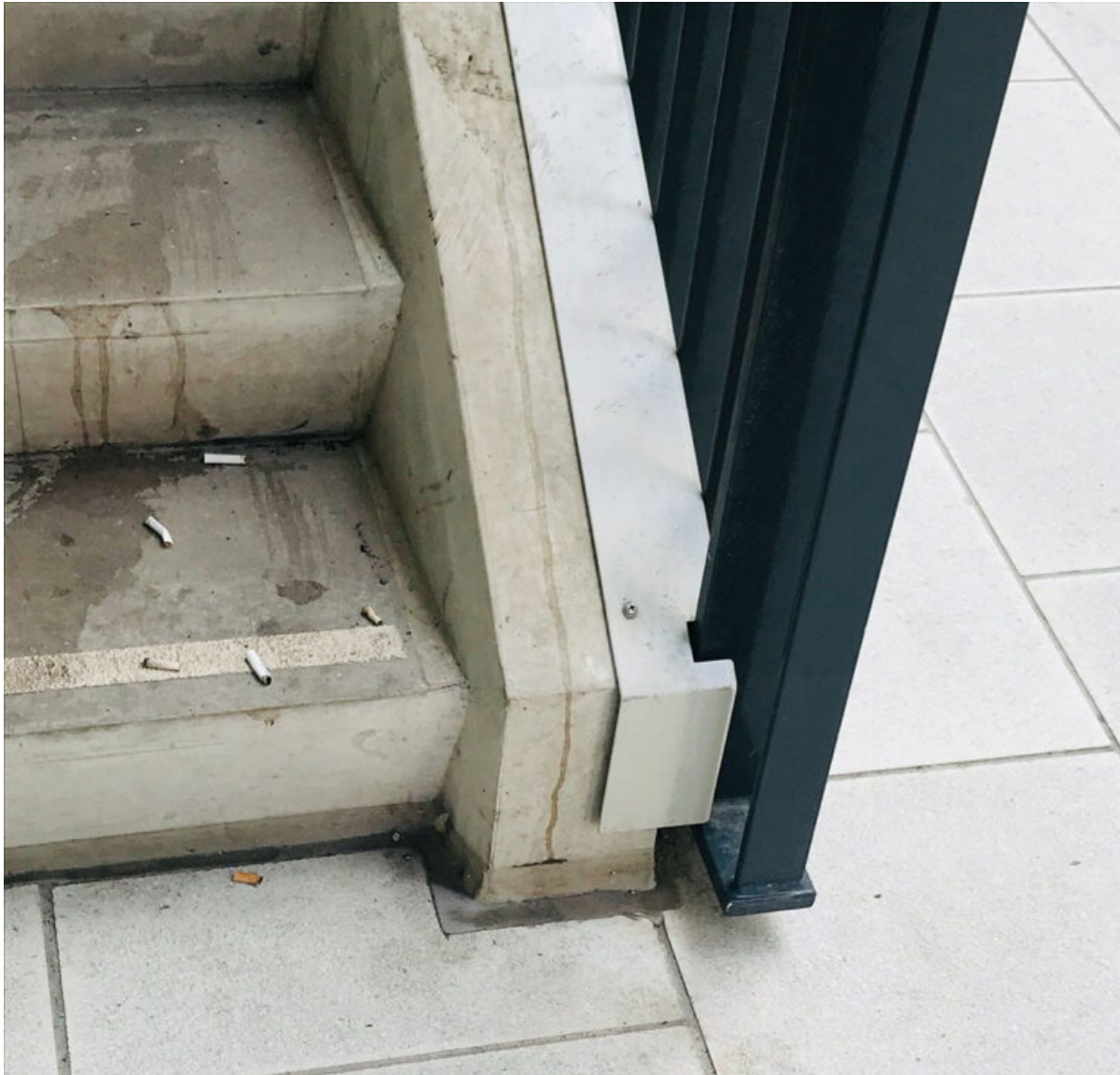
Haagse aannemersethetiek Amare (2022) / foto auteur
