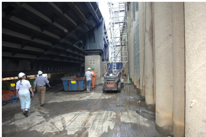
Fig. 3 Maintenance work at Maeslant Barrier. (Image: Courtesy of Rijkswaterstaat.)
