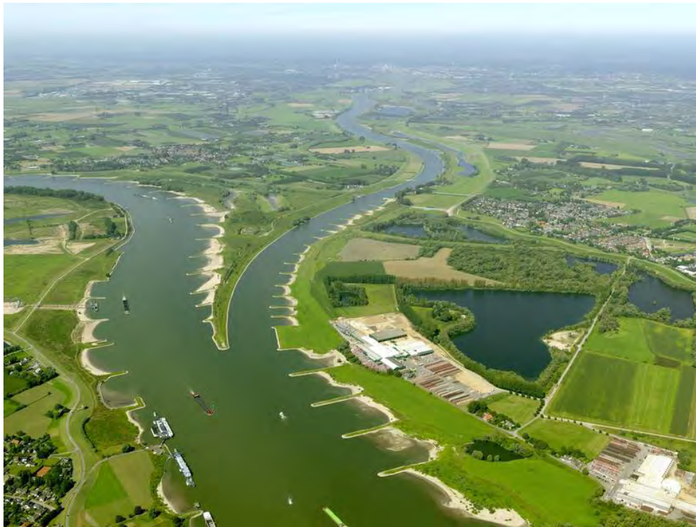
Figure 2.37: The river Waal, normalised with groynes ( Rijkswaterstaat ).
