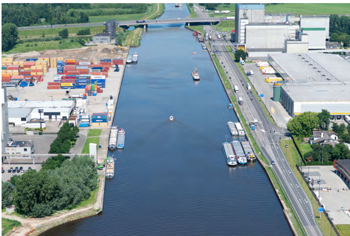
Figure 1.21: Inland container terminal at Veghel, the Netherlands ( https://beeldbank.rws.nl , Rijkswaterstaat).
