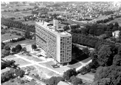
Le Corbusier, Unité d'habitation , Marseille, 1952
