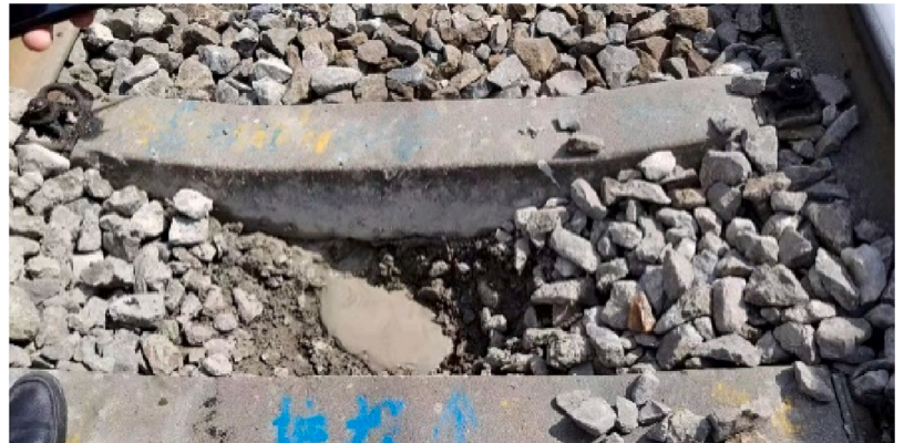
Fig. 18. Ballast layer fouling.
