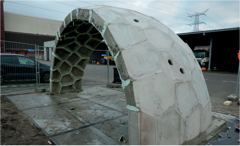
Afbeelding 4 Case Green Dome, 3D betonprinten en parametrisch ontwerpen.
