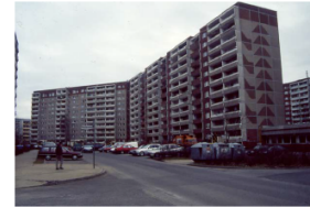
Figuur 2.2: Typende balkon-gevel van een WBS-70/11 gebouw.
