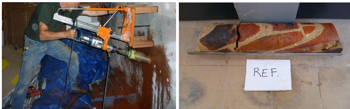
Fig. 7. Links: Boren van kernen uit behandeld en niet-behandeld metselwerk. Rechts: Referentie boorkern (niet behandeld)
