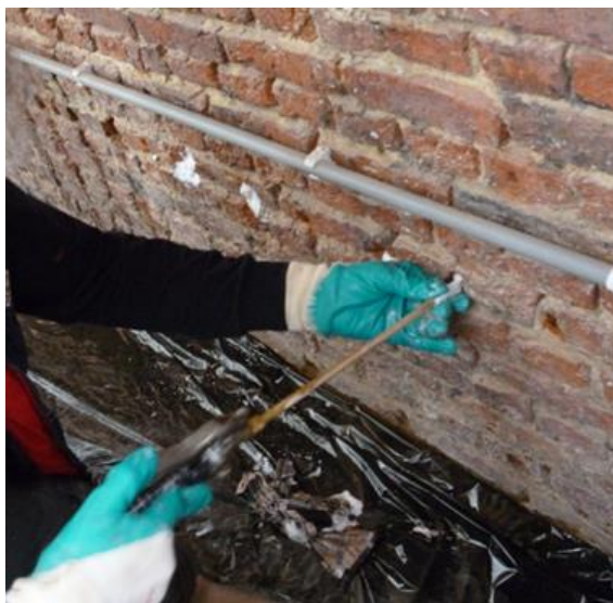
Fig. 6. Impregnering met een crème.
