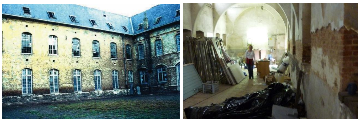
Fig. 1. Buitenzijde (links) en binnenzijde (rechts) van de proefmuur in de St. Bernardusabdij in Hemiksem (België).
