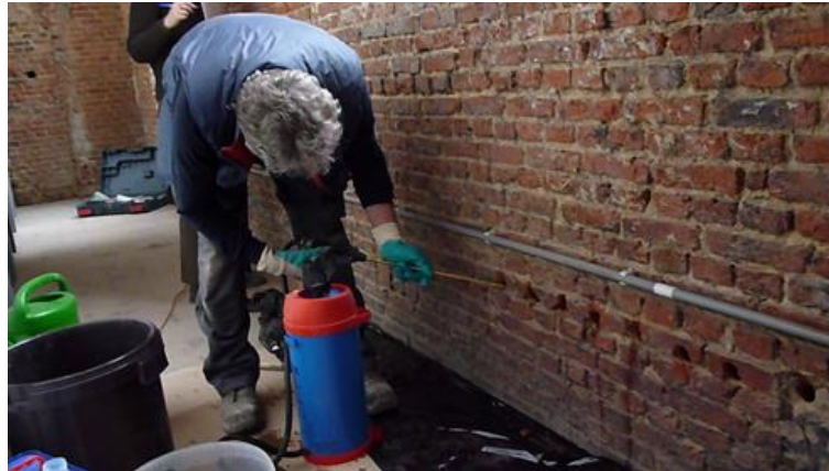
Fig. 4. Impregnering zonder druk.
