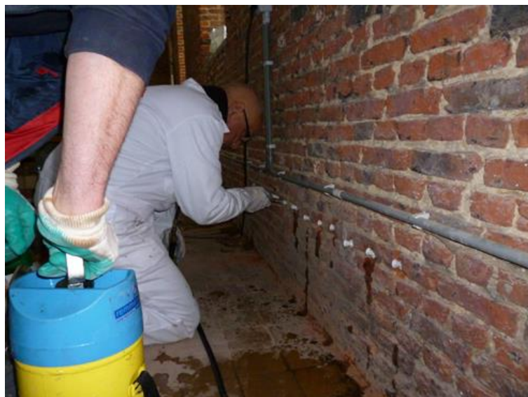
Fig. 5. Injectie met druk.
