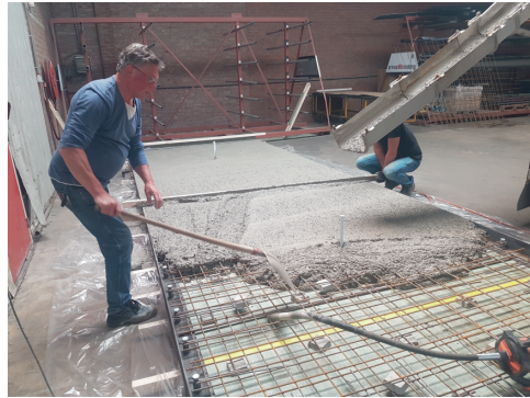
(d) Concrete casting of the floor elements.
