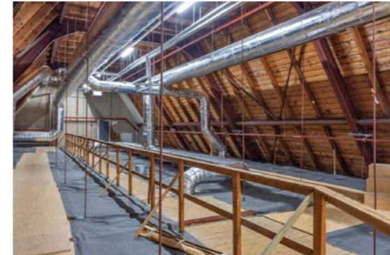
Figuur 2: Zolder van Bouwkunde, op dit moment, gebruikt voor ventilatiekanalen, met isolatie op de vloer en geïsoleerd dakbeschoot waarop leien liggen. Foto: Michiel Fremouw
